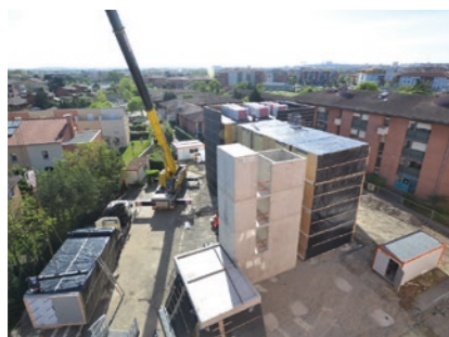
► Les unités de logement ont été levées avec le même système qu'en atelier. Le noyau, la chaufferie et le local vélo en béton n'ont pas de rôle dans le contreventement des modules, autostables et liaisonnés entre eux par des platines.
