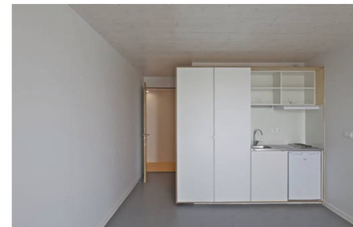
▲ Les plans des studios sont conçus comme des chambres d'hôtel. La salle-de-bain et la cuisine préfabriquées ont été assemblées en atelier.
